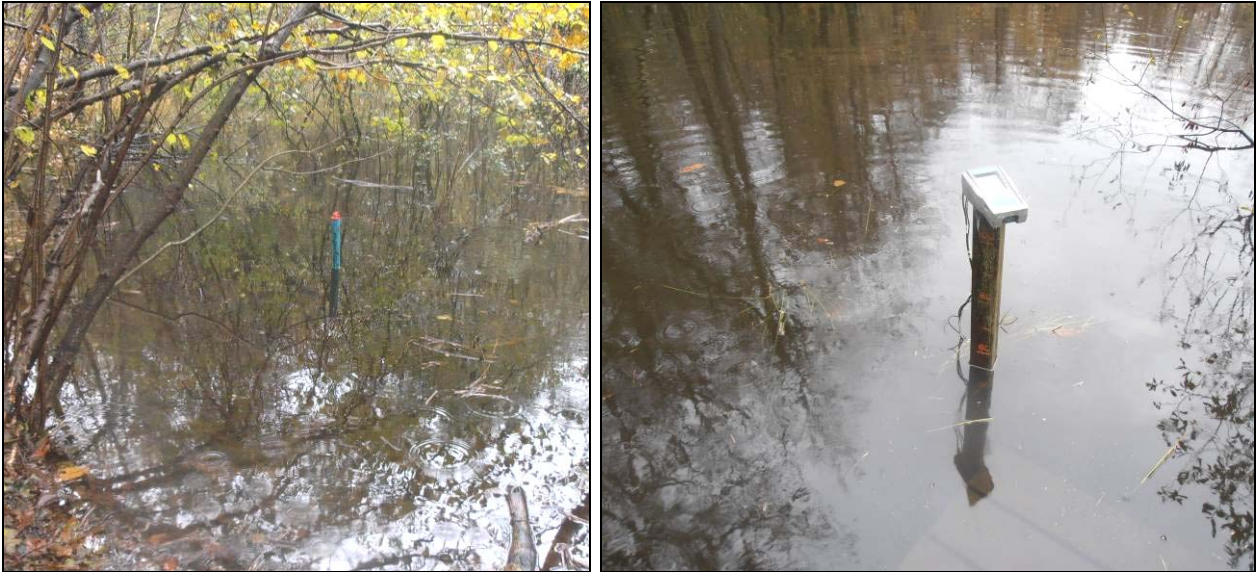
Figura 16 Piezometro e asta idrometrica (Novembre 2014)
