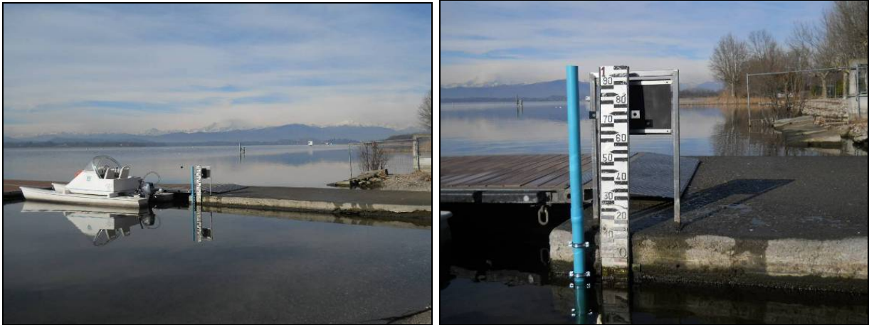
Figura 13 piezometro installato in corrispondenza del un pontile in località Schiranna
