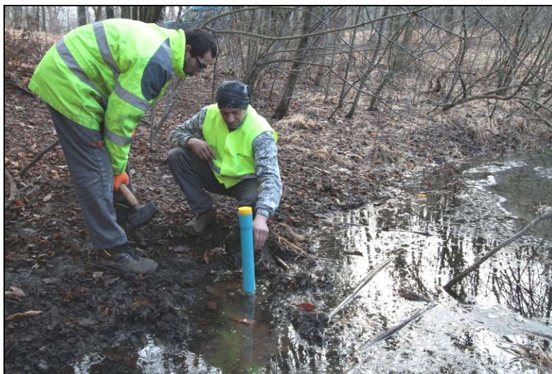
Figura 15 Installazione piezometro Gennaio 2013
