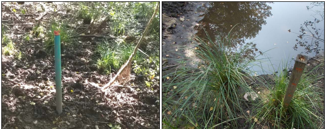
Figura 17 Piezometro e asta idrometrica (Settembre 2015)
